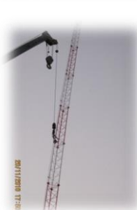
2. เสาค Self Support 30m. ม.ประปาไทย จำกัด (สาขาสาย 5 และบางเคอน)
